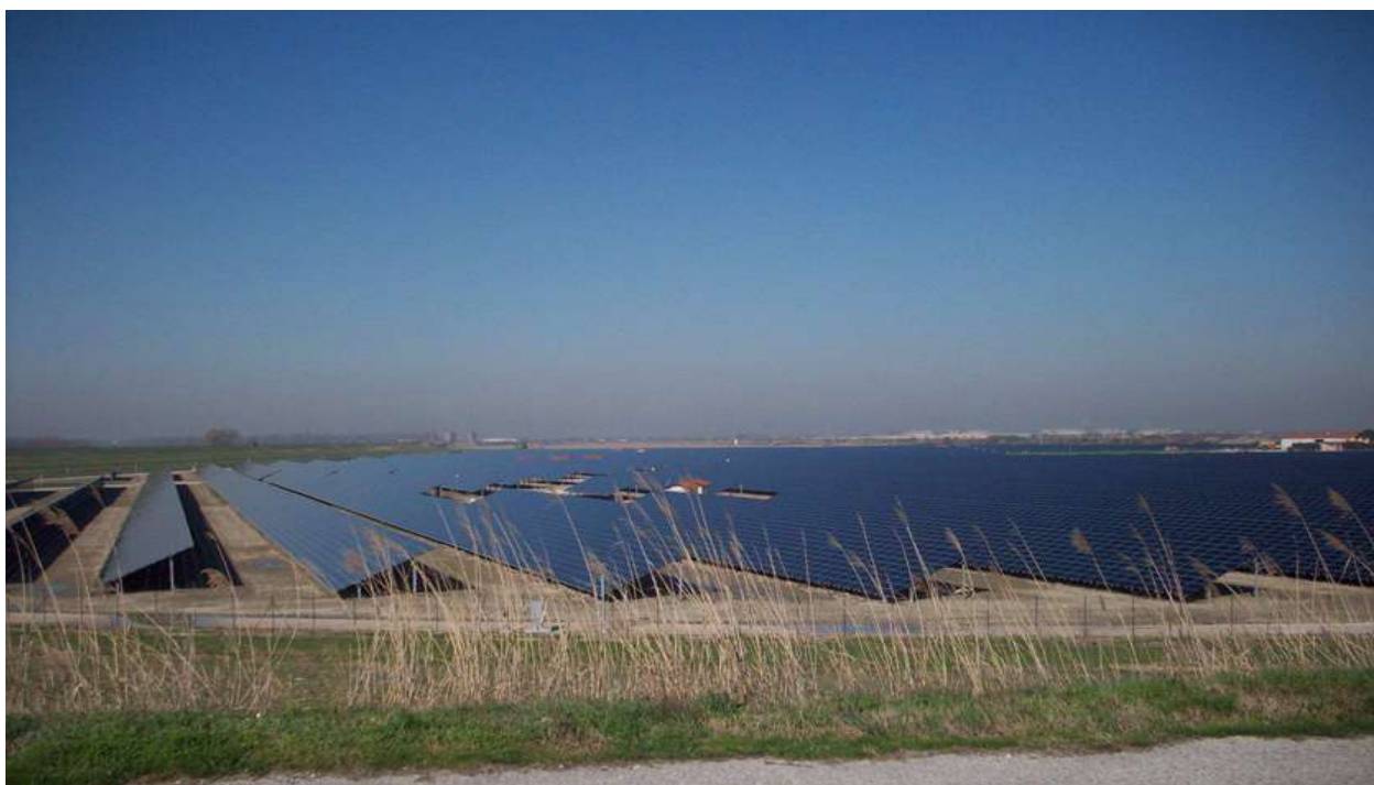
Sistema di videosorveglianza c/o impianto fotovoltaico a Cavanella Po - "Solareolica Seconda Srl"
